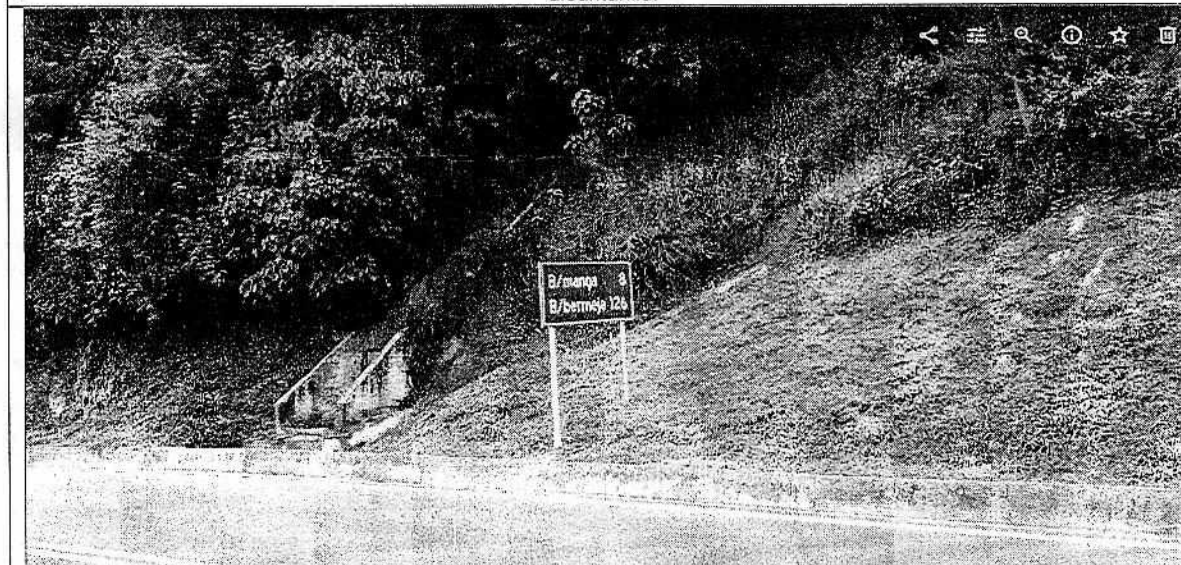
Figura 7. Estado actual del globo de vía Km 8+200, No se evidencia ocupación o perturbación sobre estructura de alcantarilla.
